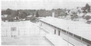
Vista parcial del sitio donde se construyó
